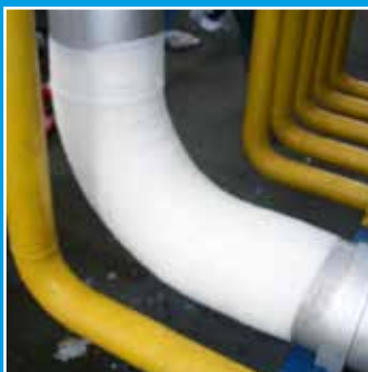
Her ser du ferdig resultat etter at reparasjonssett fra SealXpert har vært tatt i bruk.
